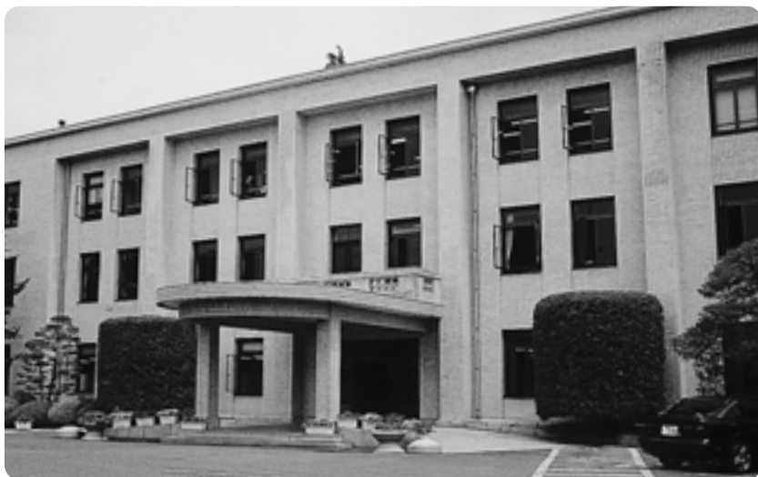
昭和9年建設の本館
